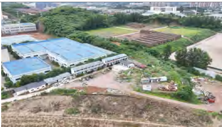
厂区南侧航拍现状
