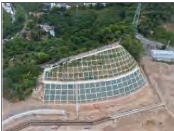
山体边坡支护
