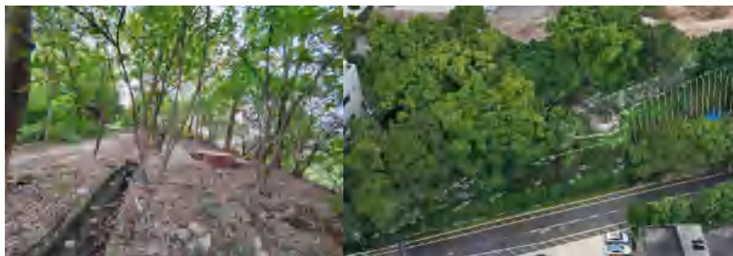
图3C-D段挡土墙场地及外侧边坡原貌
