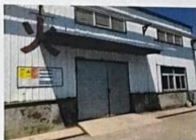
危险废物暂存间
