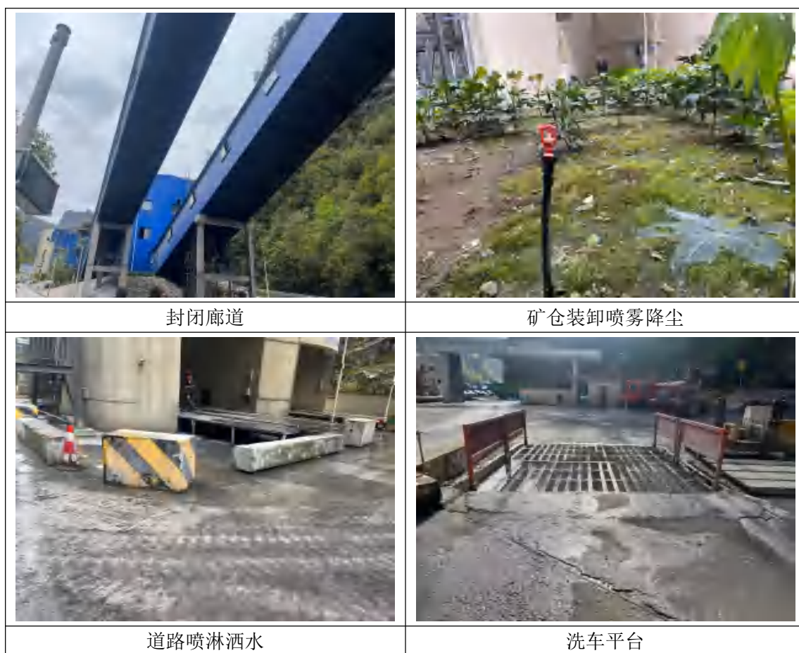
图 4.1-1 选矿装置废气治理设施及排口建设情况
