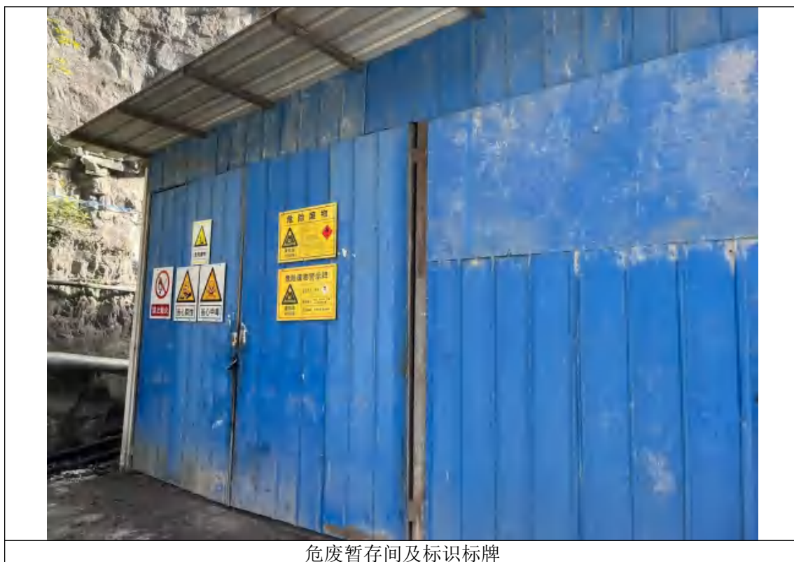
图 4.1-4 危废暂存设施建设情况
